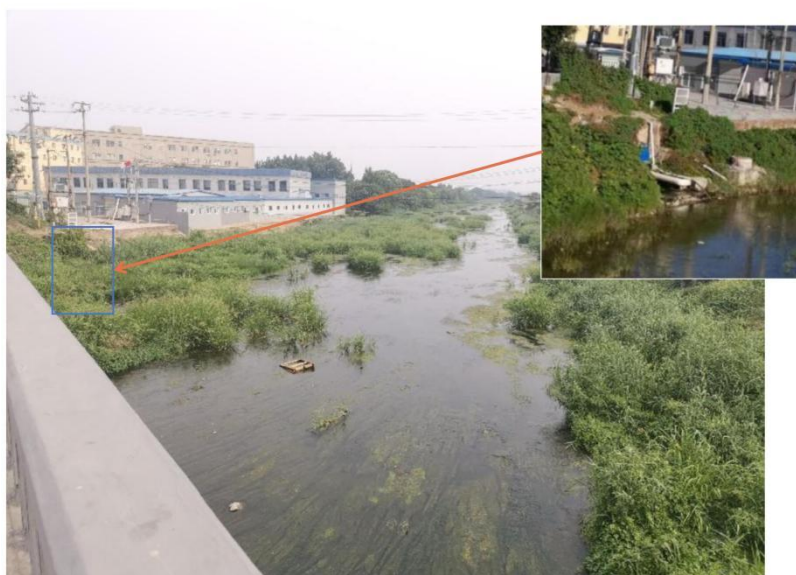
图 2.3-2 通惠河西排干渠（上游，有排污口）
