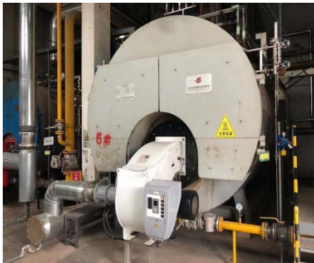
图 4.2-1 燃气锅炉照片
