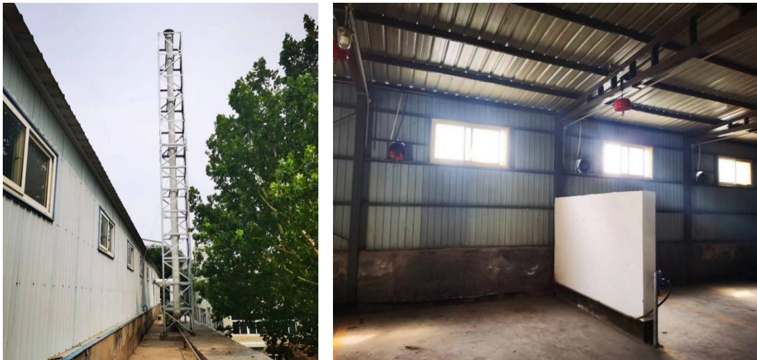
图 2.6-2 本项目外部原料依托的 2 号危险废物贮存间
