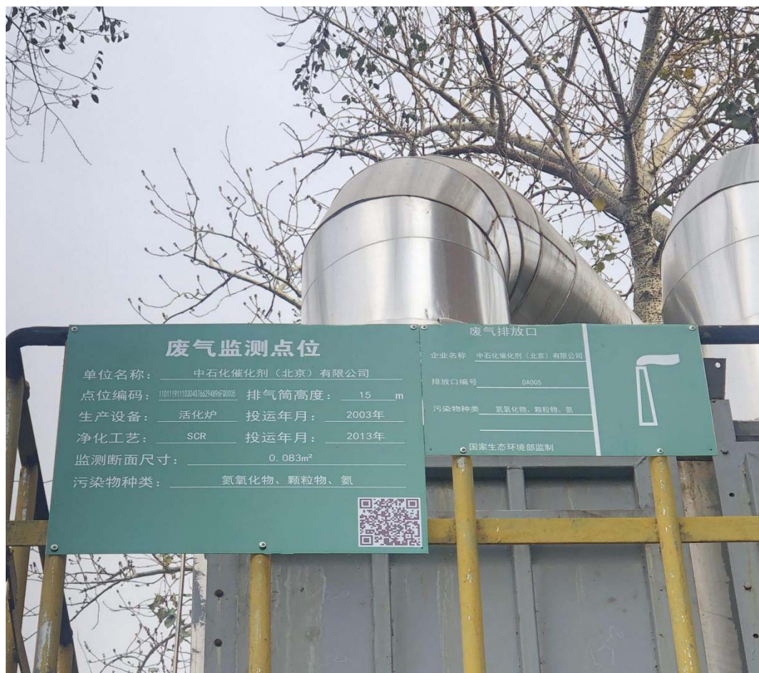
图 9.2-1 废气排污口及监测点位现状照片
