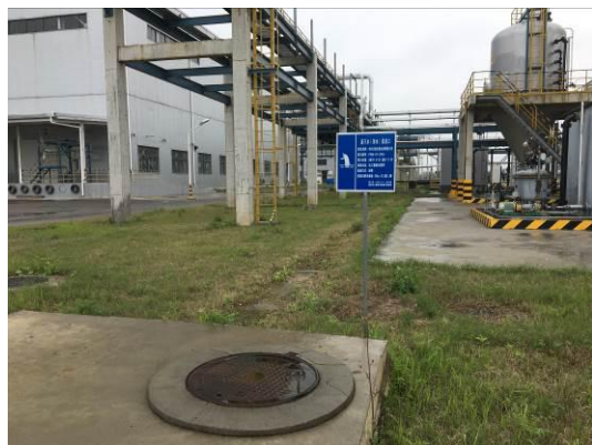
清下水（雨水）排放口
